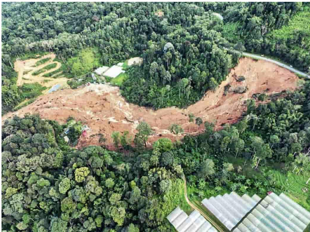
2022年 馬來西亞峇冬加里 雨季後發生大規模崩塌
